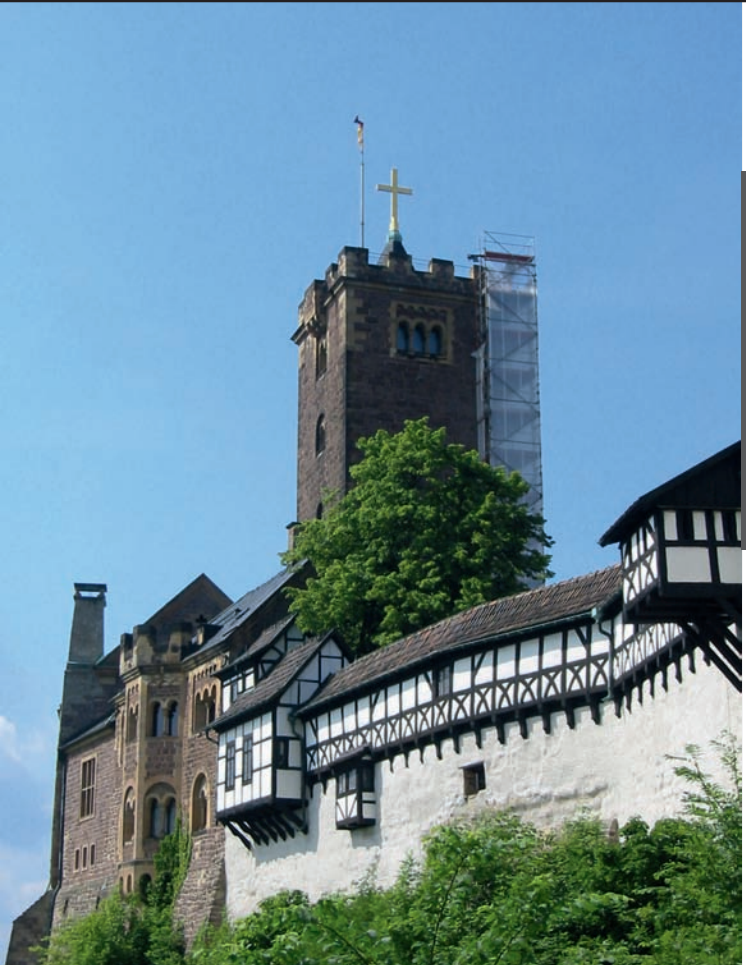
Auf der Wartburg, deren Turm sich 2008 mit Gerüst präsentiert, fand Luther Zuflucht und Zeit für seine Bibelübersetzung.
